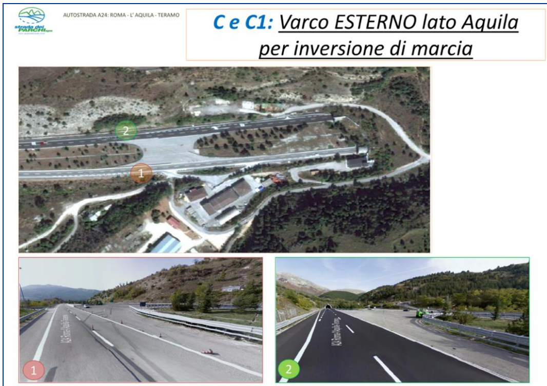
Figura 26 – Varco esterno lato L’Aquila
